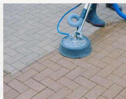
スピナーによるインターロッキング洗浄
