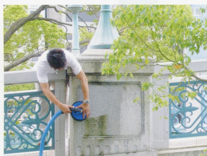
SX-7による外壁洗浄
