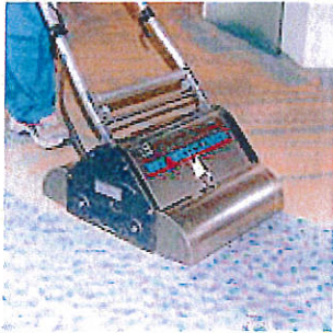
④リノベーターでコンパウンド回収
