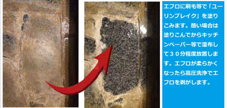
エフロに刷毛等で「ユーリンブレイク」を塗りこみます。酷い場合は塗りこんでからキッチンペーパー等で湿布して30分程度放置します。エフロが柔らかくなったら高圧洗浄でエフロを剥がします。
